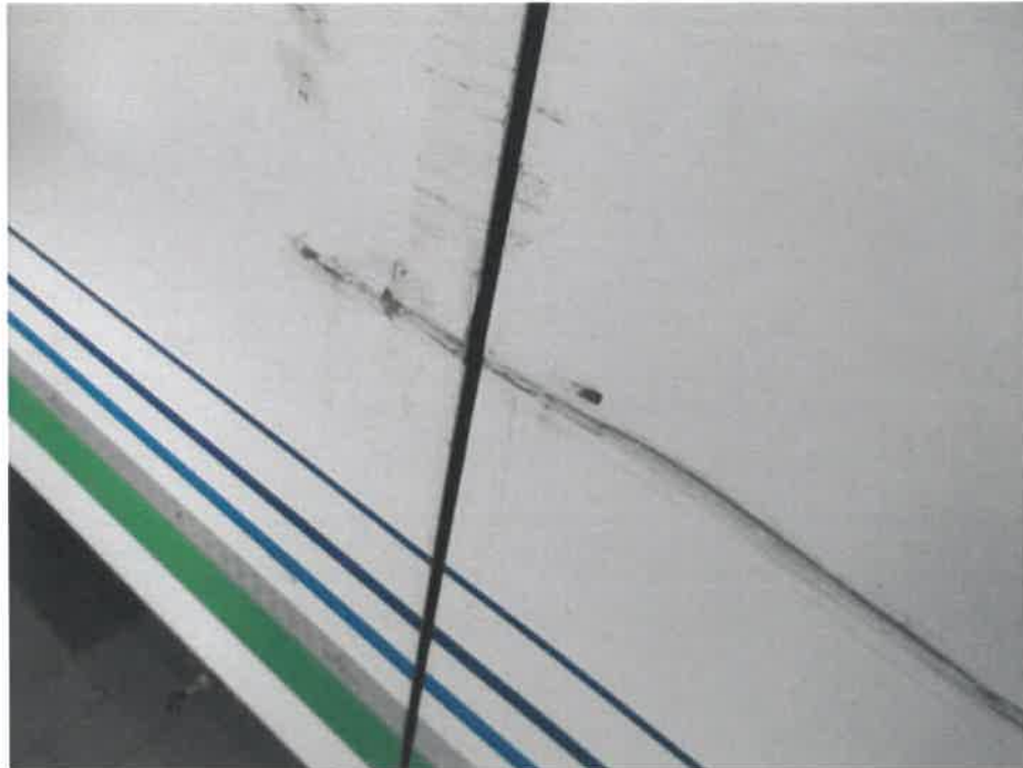
Bild 19 : Seitenklappen rechts eingedrückt/verschrammt
