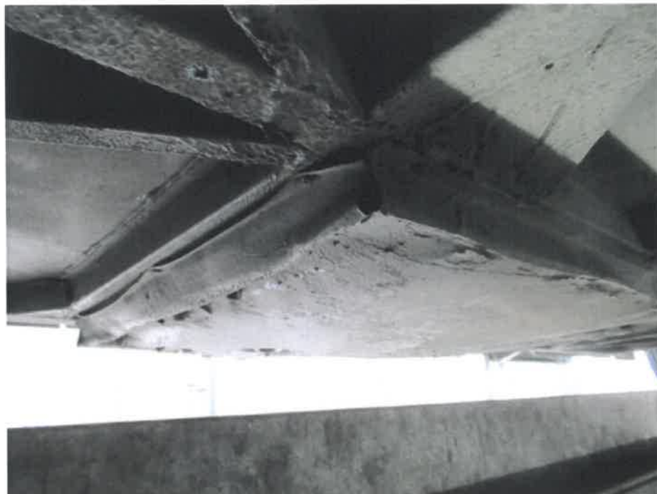
Bild 34 : Toilette stark verschmutzt/Unterboden deformiert
